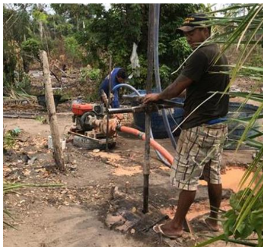
Figura 01: Método de perfuração de poço semi-artesiano, realizado na aldeia Yarumê.
